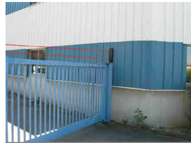
La barrière à infrarouge actif autonome So Beam S de Sorhea permet de détecter le franchissement d'un portail ou d'une barrière levante durant les heures de fermeture. Elle s'installe très facilement sans génie civil. So Beam S est prévu pour s'intégrer aux VMS.
